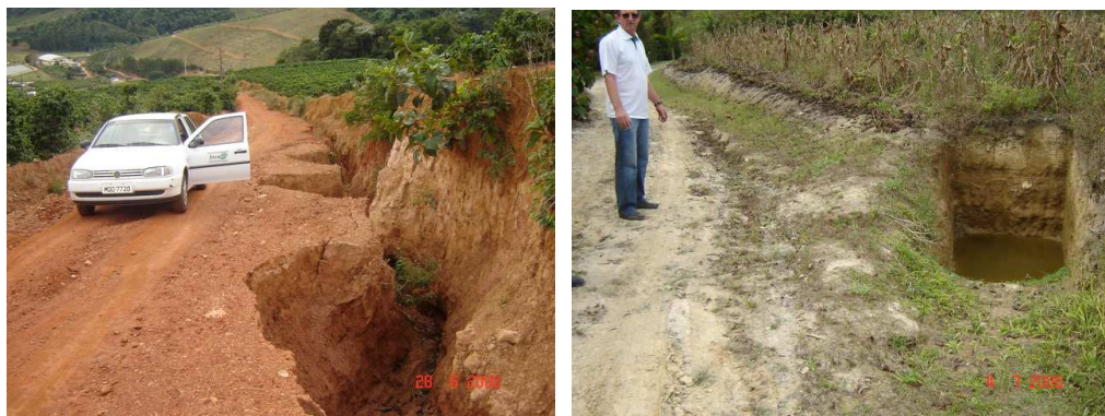
Figura 4: Erosão em estrada vicinal (à esquerda) e sistema de caixas secas para retenção de águas de chuva (à direita).
